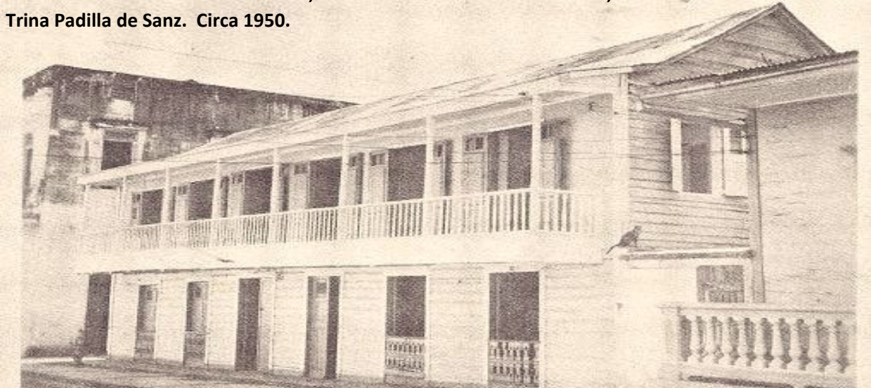
Presentamos este edificio de madera antigua como un ejemplo para comprobar que en el resto del casco urbano predominaba este tipo de estructuras; muy similar a las casas que existieron en las Calles: Antonio R. Barceló, Santa María, Pinta y Niña. Foto cortesía de Byron Mitchell.
